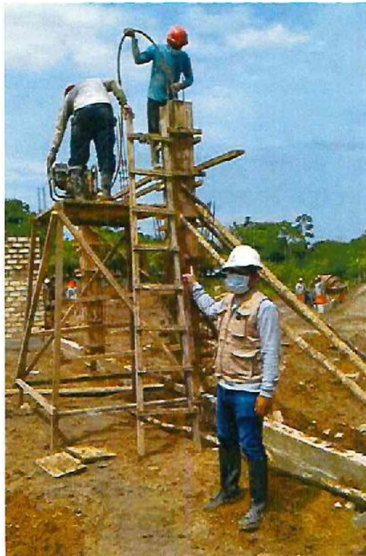
Encofrado de columna con éxito.
