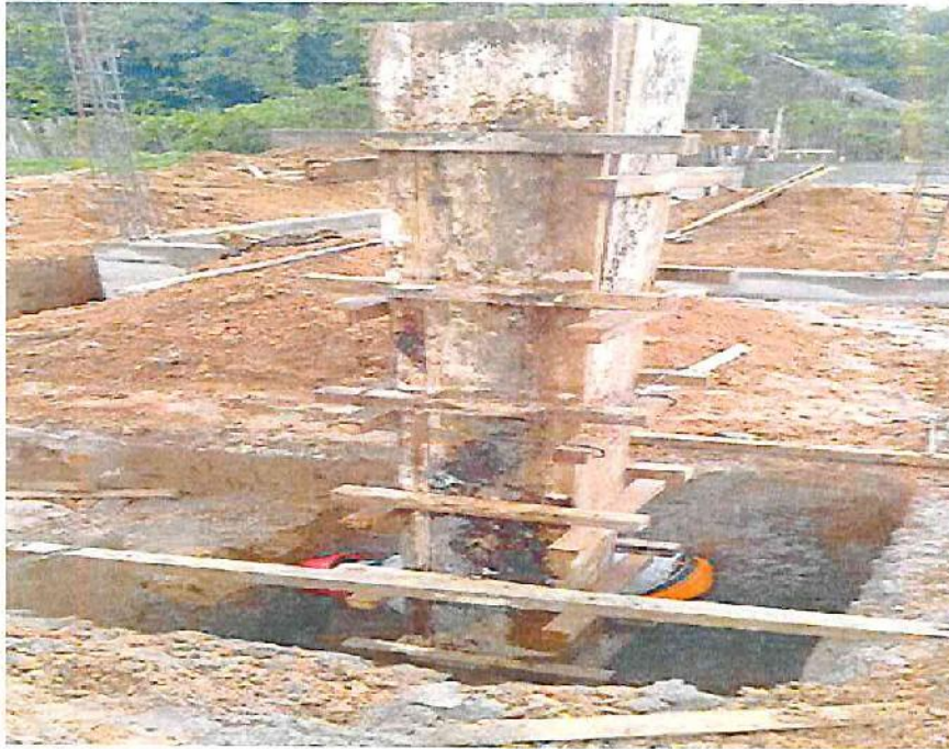
Encofrado de columna.
