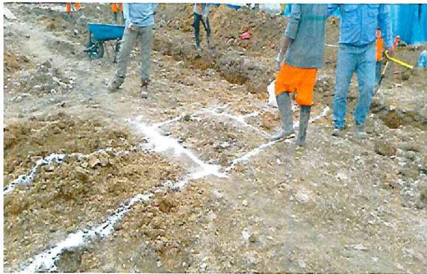
Trazados para la excavación de zanjas.
