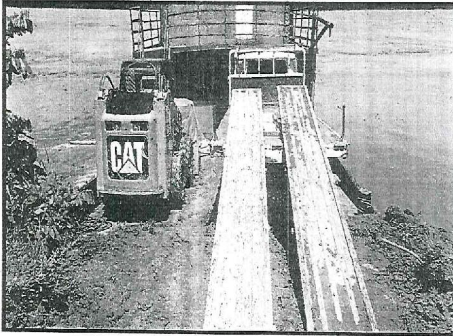
MAQUINARIA EN PUNTO DE OBRA
