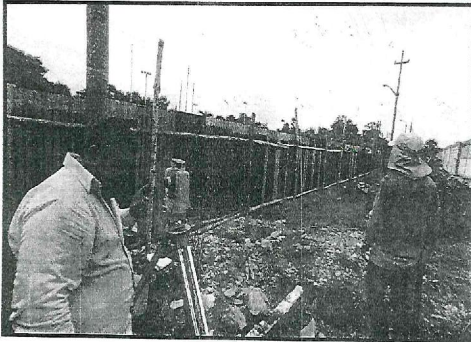
TRAZO, NIVEL Y REPLANTEO
