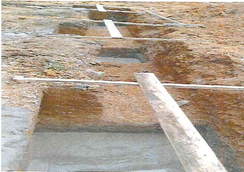
Solado de falsa zapatas.
