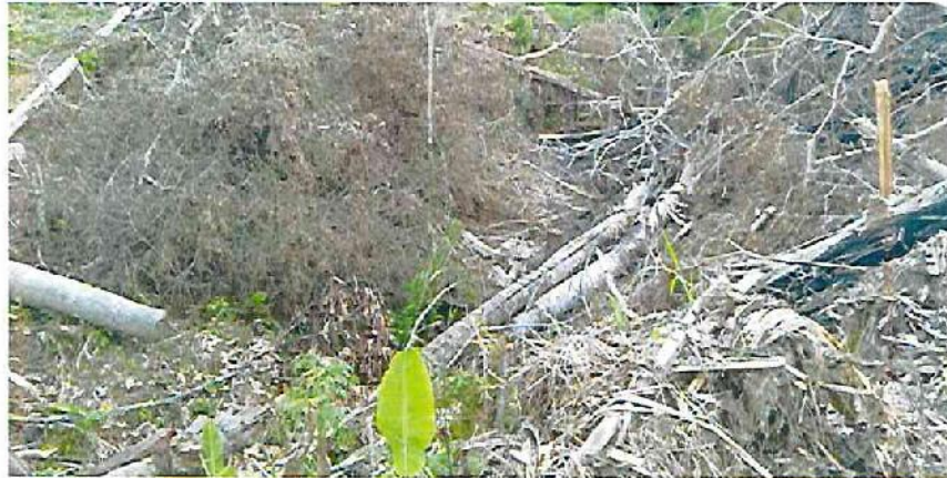
Limpieza de terreno.
