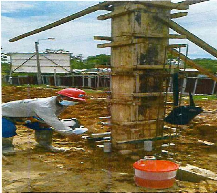
Proceso de encofrado en columna.
