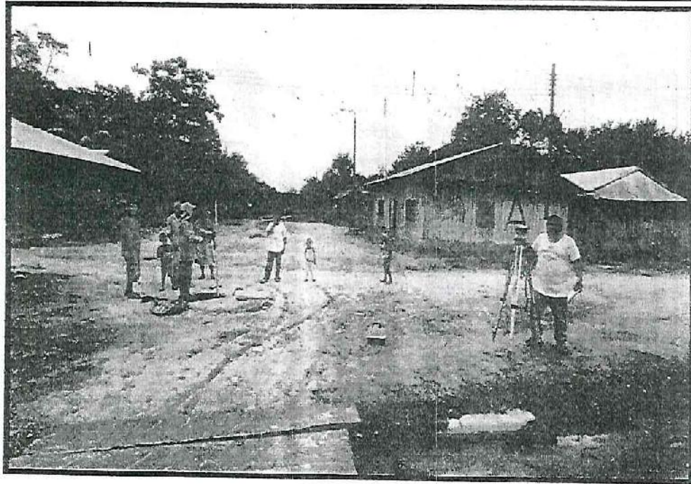
TRAZO, NIVEL Y REPLANTEO
