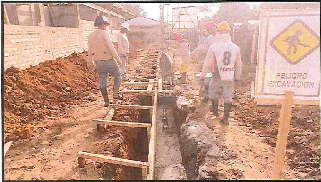
PLANTADO DE COLUMNAS Y VACEO EN CIMENTO CORRIDO
