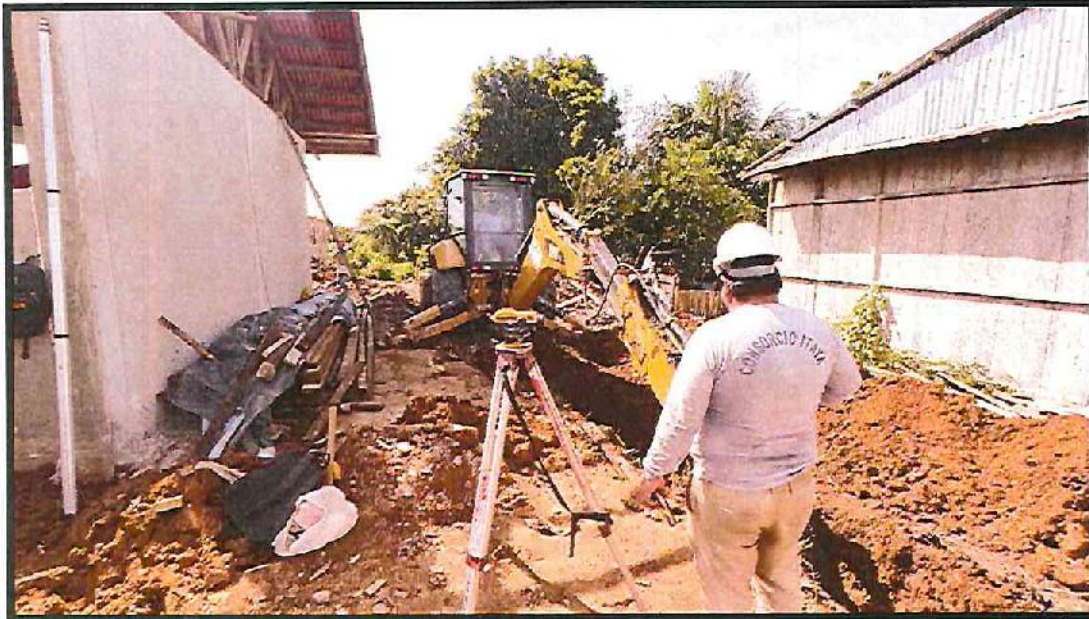
EXCAVACIÓN DE ZANJA
